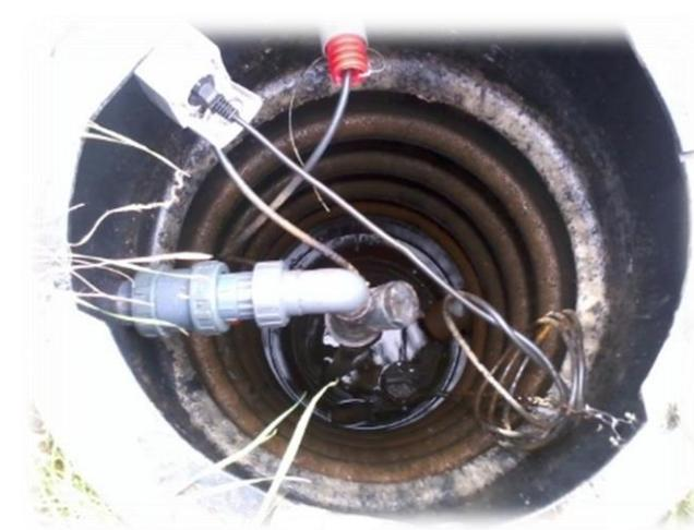
Le poste de relevage doit être vérifié tous les 6 mois. Il nécessite un entretien régulier (nettoyage de la pompe à l'eau claire et vérification du fonctionnement de celle-ci).
